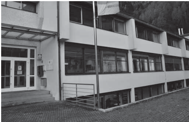
Das neue Oberschulzentrum ...
